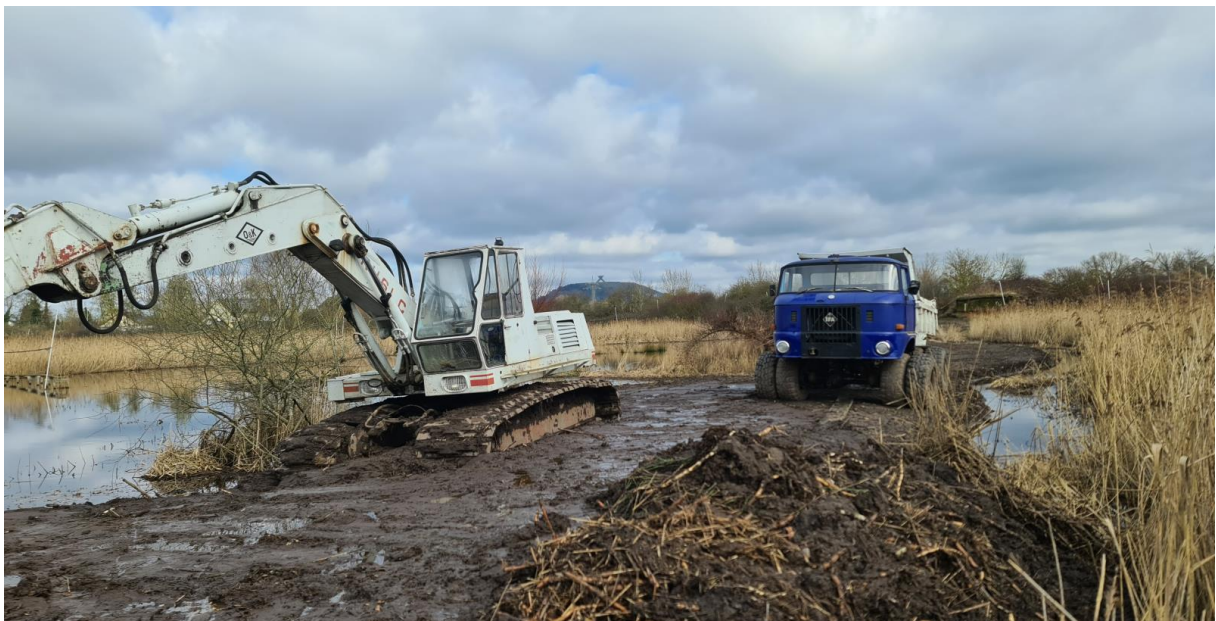
Abbildung 1: Zustand des IKEA-Biotops nach Abschluss der Modellierungsarbeiten im Februar 2024. Der Abtransport des Erdaushubs, welcher in der Baustraße eingebaut wurde, musste aufgrund des hohen Wasserstands auf die Sommermonate 2024 verschoben werden.
