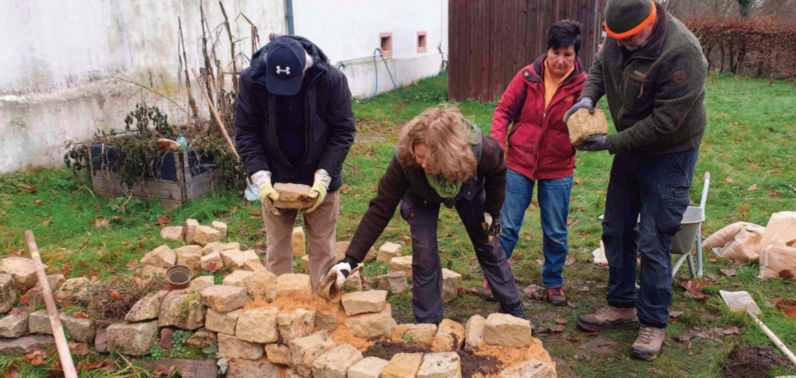
Bau einer Kräuterspirale an der Scheune Neuhaus
