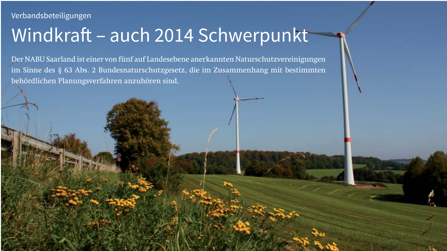
Windpark Schiffweiler an der B 41
